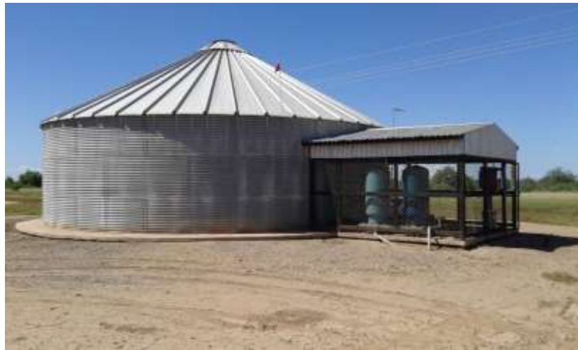
Figura 15: Cisterna que abastece sitio Destete 2.4 con capacidad de 150,000 lts.
