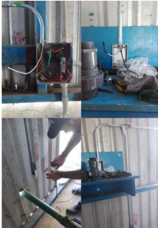
Figura 9: Instalación de Canaletas y Conexiones Eléctricas
